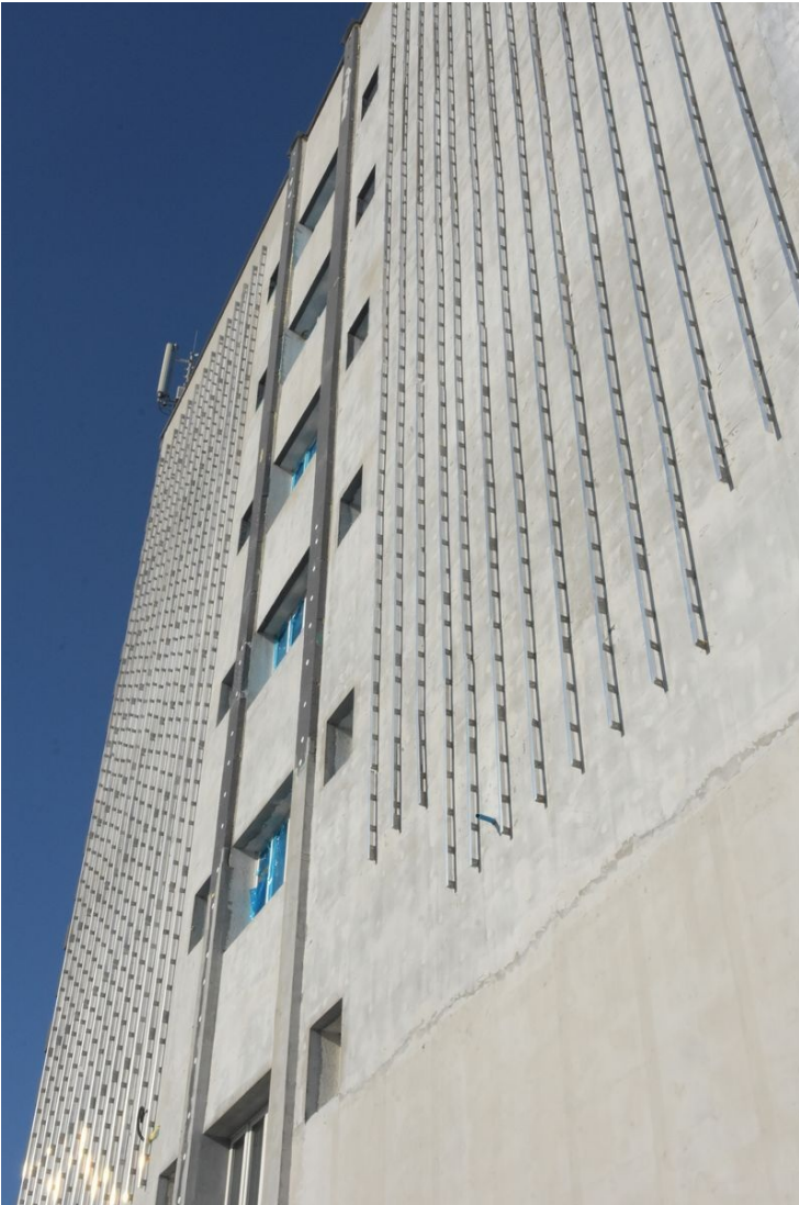
Stan budowy na dzień 23.05.2018 r.
